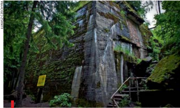
Wilczy Szaniec, system bunkrów niedaleko Kętrzyna, to jeden z najciekawszych obiektów turystycznych w naszym regionie
